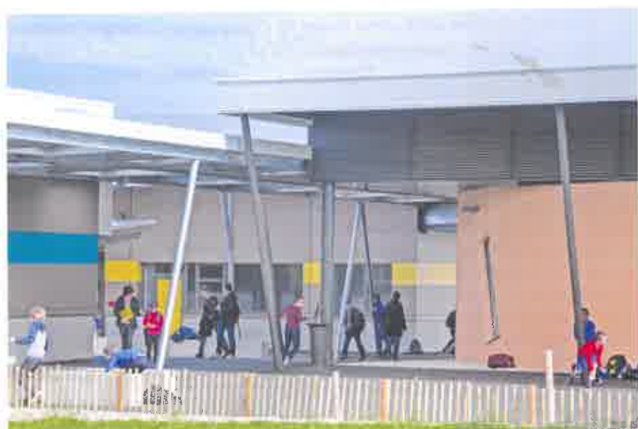
Tout a été prévu pour le bien-être des élèves, à l'image de ces auvents pare-soleil qui protègent les salles de classe.
